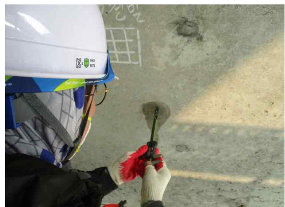
b. 탄산화 깊이 측정
